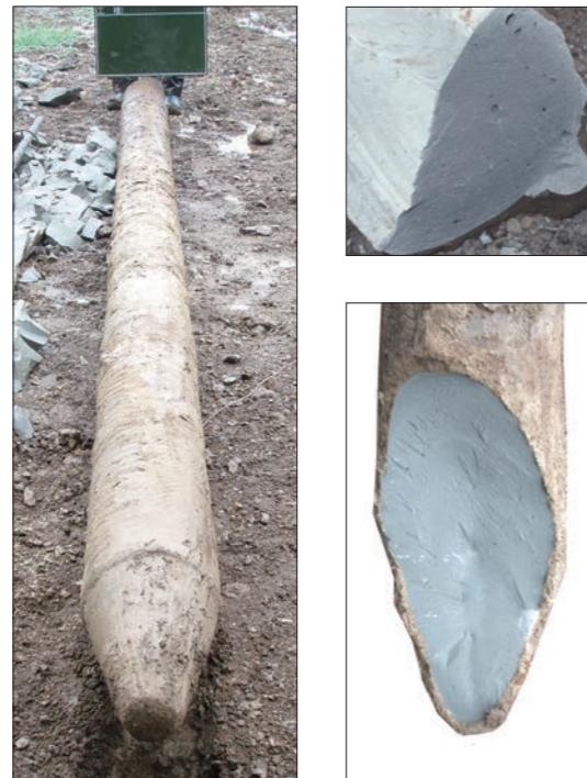
掘り起こしたピュアパイル
